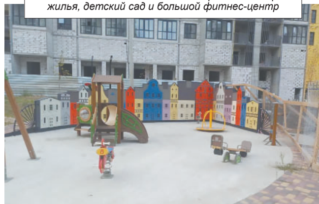
В посёлке Путёвка возводится современный жилой комплекс «Цветной бульвар», в котором планируется сдать около 150 тысяч квадратных метров жилья, детский сад и большой фитнес-центр
