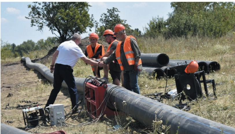
трех водоводов общей протяженностью 2,7 км. Эти сети снабжают водоснабжением самые густонаселенные районы города Брянка. Изношенные трубы заменяются на новые пластиковые диаметром 400 мм, что обеспечит не только бесперебойную подачу воды в районы, которые испытывают ее недостаток, но и улучшит качество самой воды.
