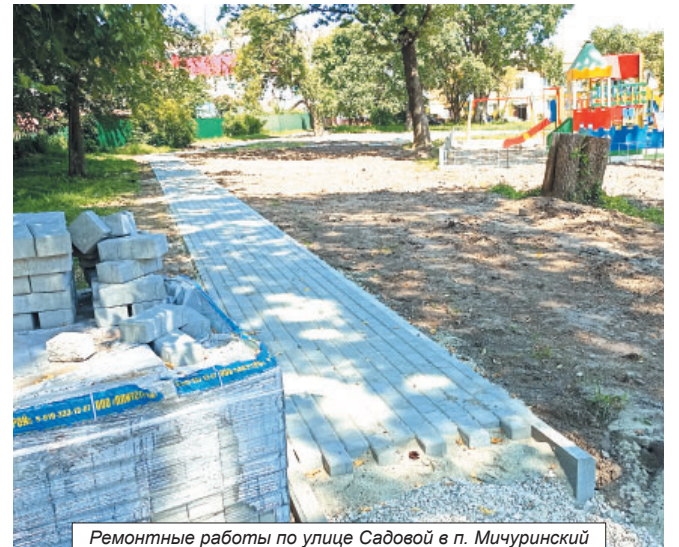
Ремонтные работы по улице Садовой в п. Мичуринский
